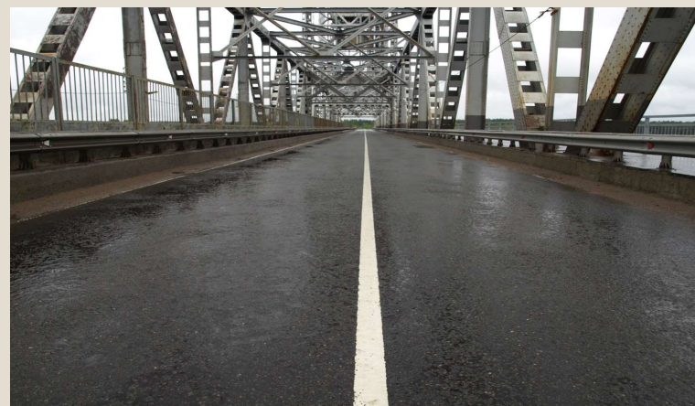
Через 1,5 года после полного ремонта гидроизоляции и покрытия, 2010г.
